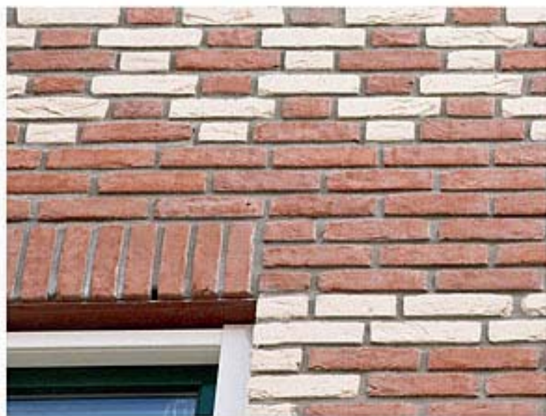
Vlak naast de rollaag liggen twee koppen boven elkaar, een witte en een rode. Ook deze 'ingreep' was noodzakelijk, en goedgekeurd, om in verband te blijven
